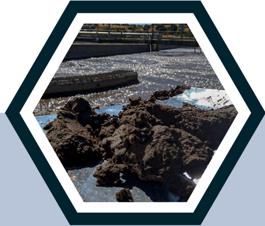
Deshidratación de lodos
